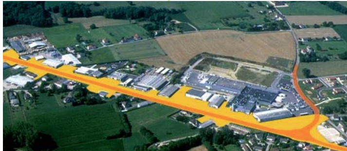
Une absence de logique globale d'aménagement de l'espace (alignement bâti, cheminements, organisation des accès et stationnements...)
