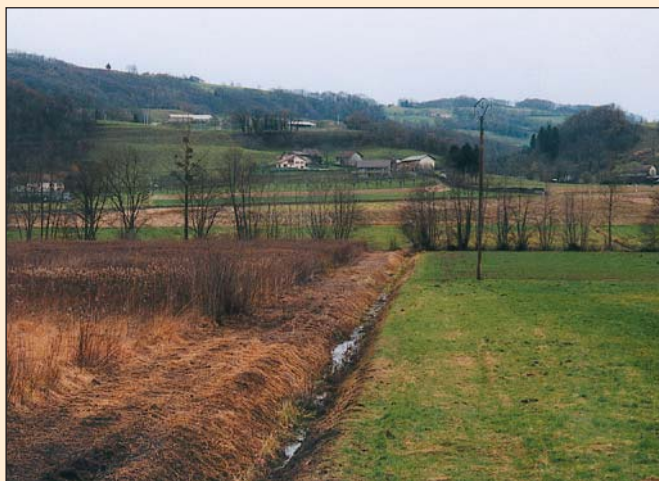
Un canal profilé à la pelle mécanique.
