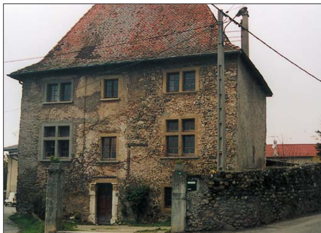
La grosse maison dauphinoise construite en galets et pierre. Les fenêtres sont à meneaux et la toiture à quatre pans et coyaux.
