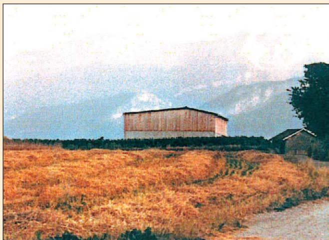
Le bardage bois placé en dessous de la toiture donne une meilleure qualité architecturale.
