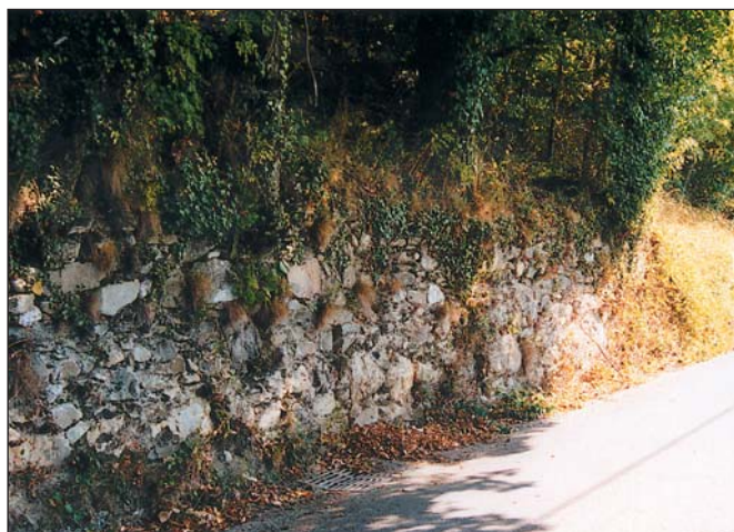
Talus soutenu par un muret de pierres sèches.
