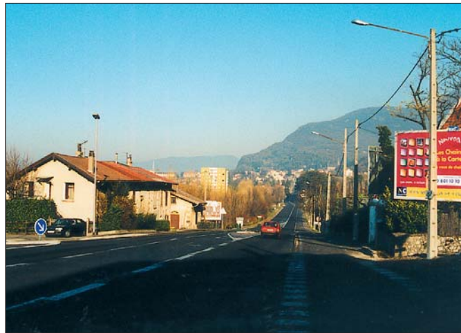
La largeur de la voie est surdimensionnée et l'espace indifférencié ne réserve pas une place confortable au piéton.
