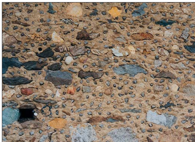
Mur en pierres de diverses provenances.
