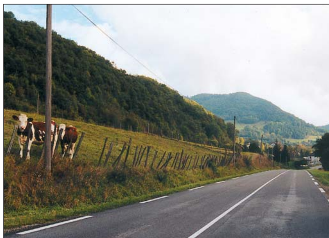
Les routes départementales ne nécessitent pas forcément des aménagements coûteux. Il faut éviter de surdimensionner la largeur de la chaussée.
