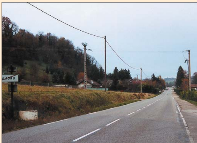
Le traitement des bas côtés a un rôle important pour l'image de la route. Un bas côté enherbé n'empêche pas le stationnement.
