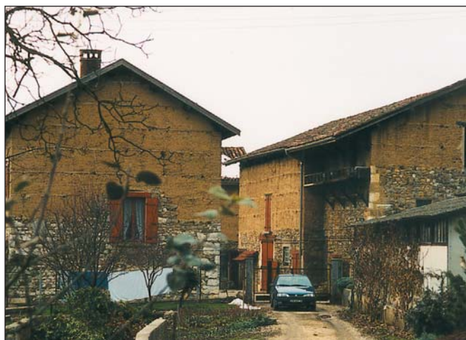
Mur en pisé à soubassement de galets.
